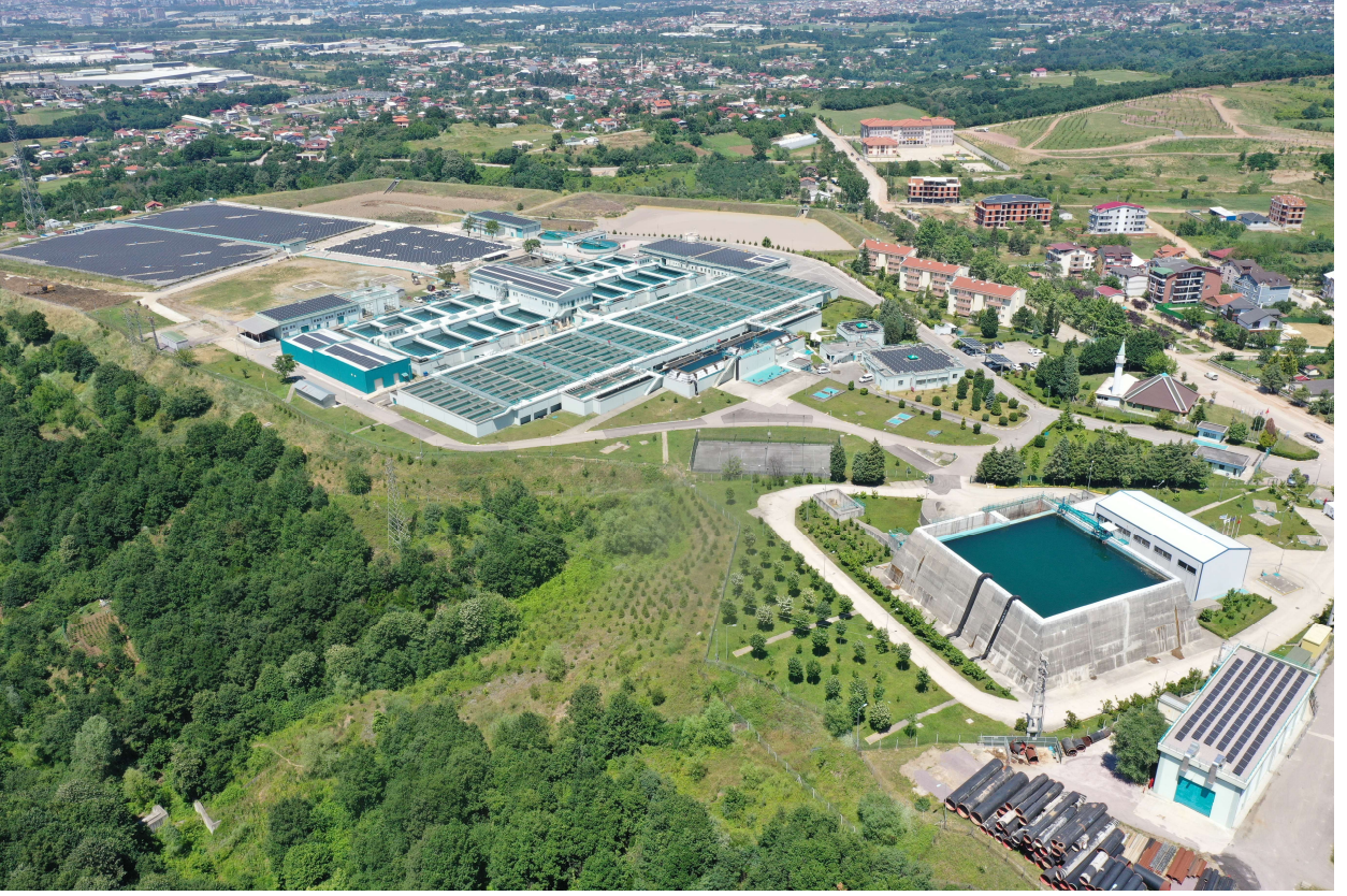
İzmit İçme Suyu Arıtma Tesisi Güneş Enerjisi Santralleri (GES)
